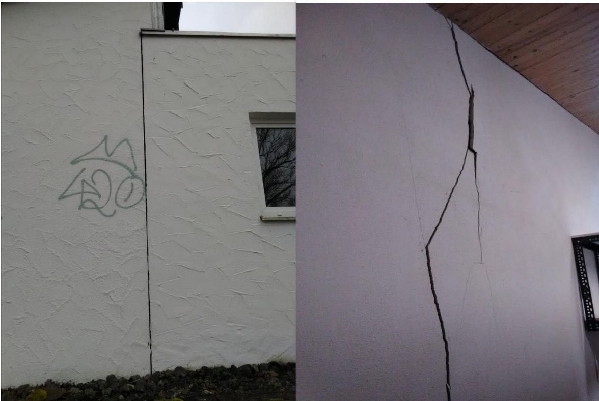
Die Bodenplatte steht auf Fundamenten. Es ist davon auszugehen, dass die Fundamente nicht tief genug (bis zum Mutterboden) gegründet sind. Die Bodenplatte hätte zur Not mit Pfählen oder Plomben gesichert werden müssen. Folglich ist die Boden-
