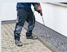
In die Bohrlöcher werden Injektionslanzen aus Kupfer oder Stahl eingesetzt.
