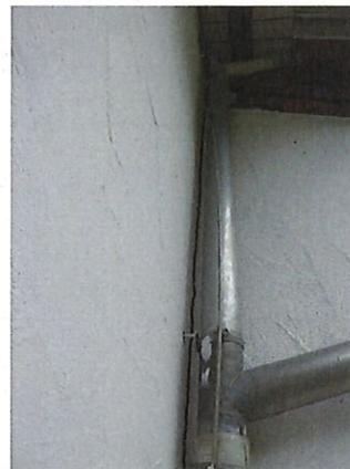
**Bauschäden:** *Deutlich erkennbare Rissbildungen am Bauteilübergang und im Mauerwerk*
