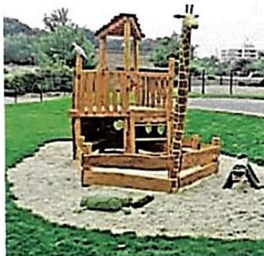
Spielschiff aus Robinienholz, anstelle Netzaufstieg mit kleiner Rutsche geplant
